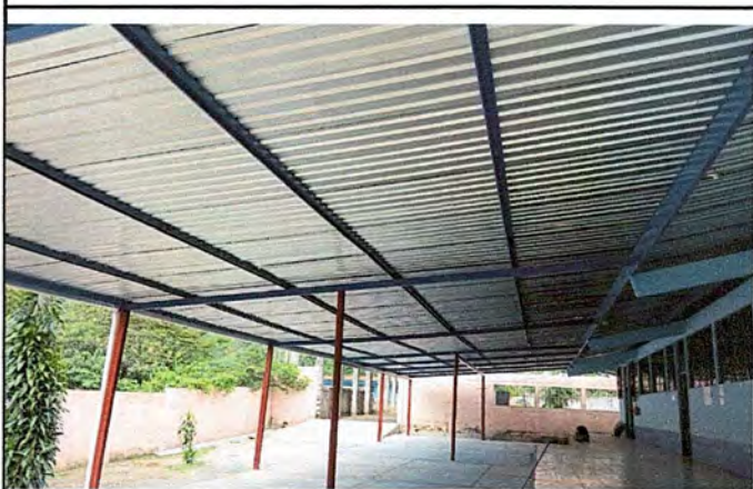
Foto 4: Vista interior del techo.
