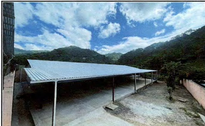
Foto 1: Sustitución de cubierta del edificio escolar.
