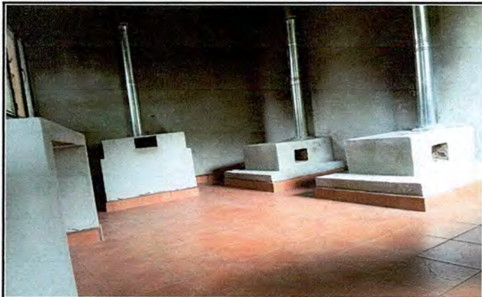
Foto 1: Mejoramiento de cocina.
