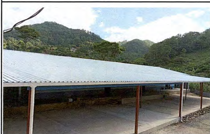
Foto 3: Ampliación de piso y techo con cubierta y estructura tipo pórtico.
