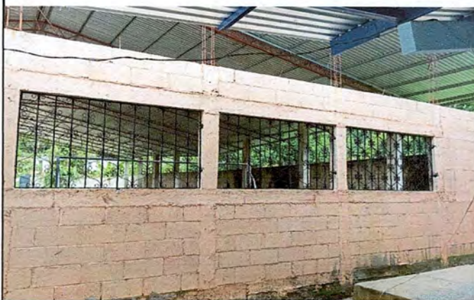
Foto 4: Mejoramiento de ventanales con balcones.
